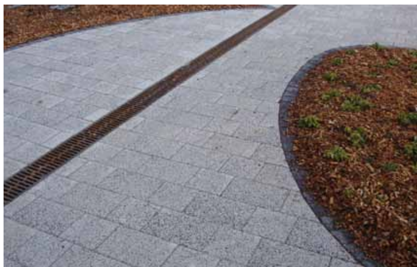
Detajl vzorca zaključka z tlakovci
