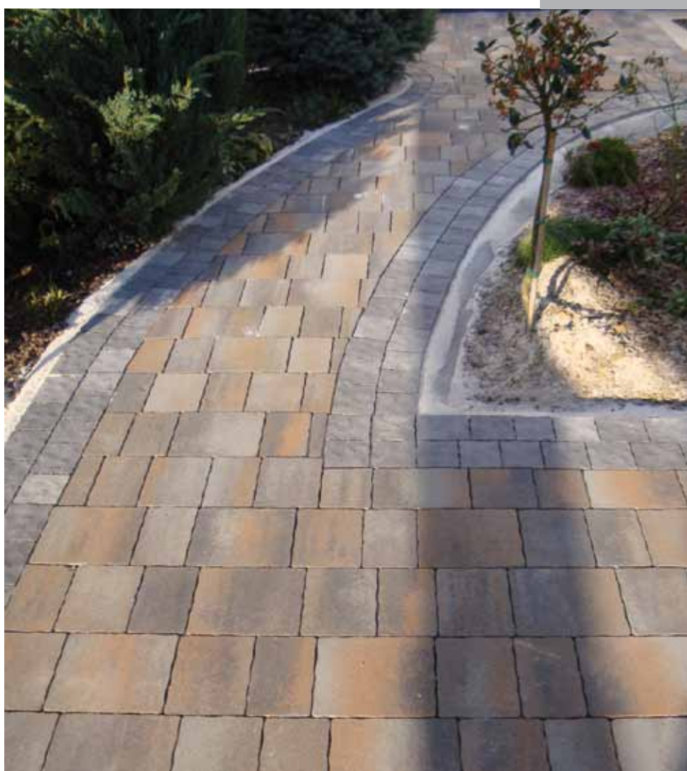
Obbetonirana dvojna obroba ali uporaba sistema Pave edge
