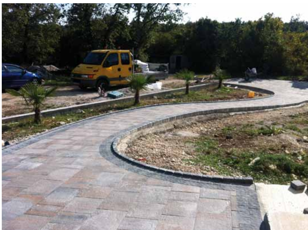
Dvojni zaključek tlakovane površine (obvezno obbetoniranje ali uporaba sistema Pave edge)
