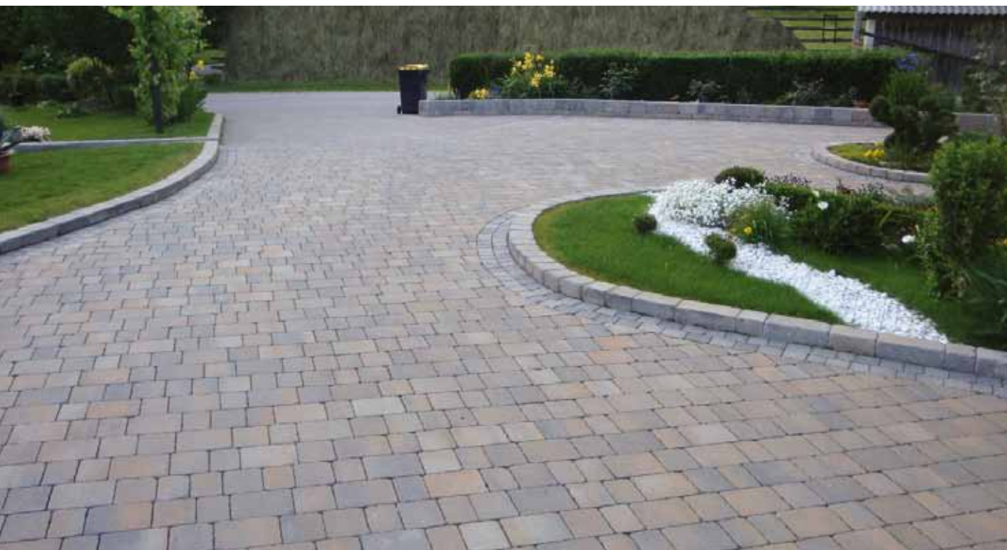
Izdelava obrobe z škarpnim elemntom Storica
