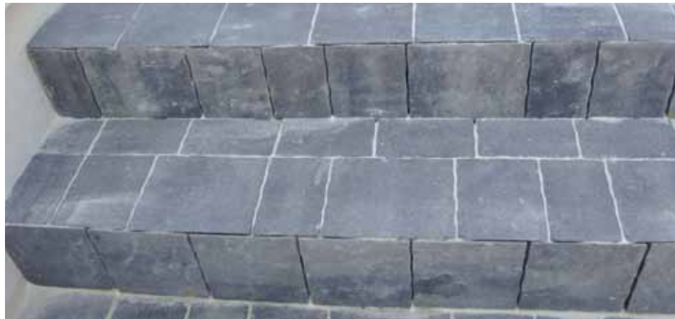
Izdelava stopnic iz tlakovcev Via Appia (rezano pod kotom 45 °)
