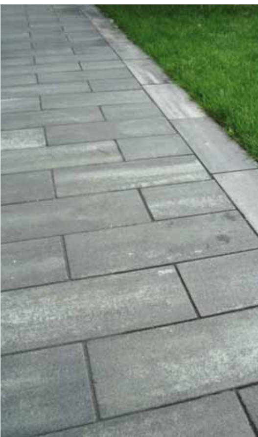
Enojna obroba z 90 stopinjskim zasukom - tlakovec Ferrara v višini zelenice
