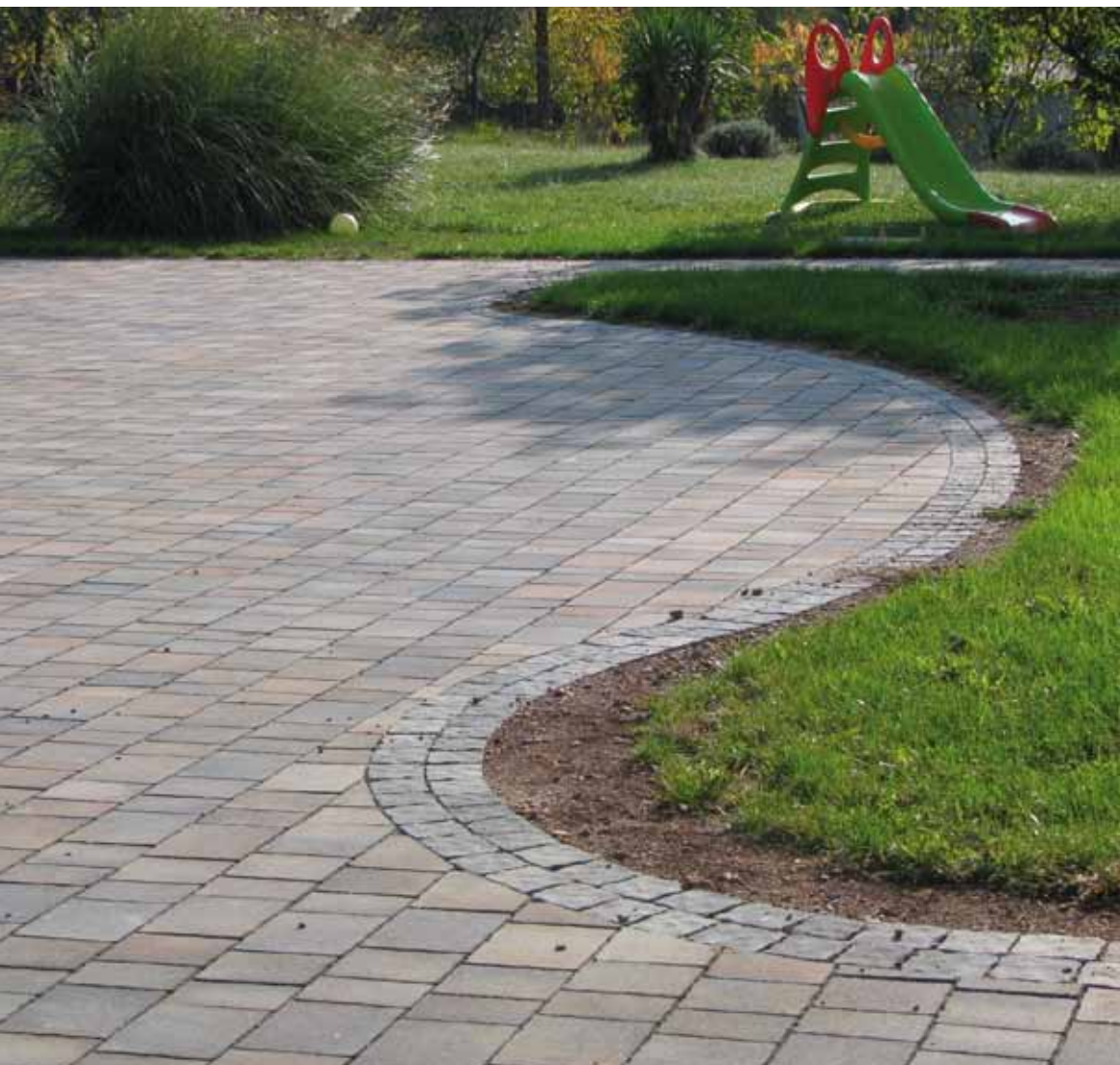
Dvojni zaključek tlakovane površine (obvezno obbetoniranje ali uporaba sistema Pave edge)
