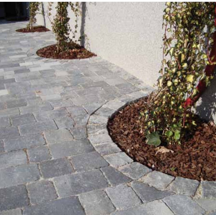
Izdelava enojne obrobe (obvezno obbetoniranje ali uporaba sistema Pave edge)
