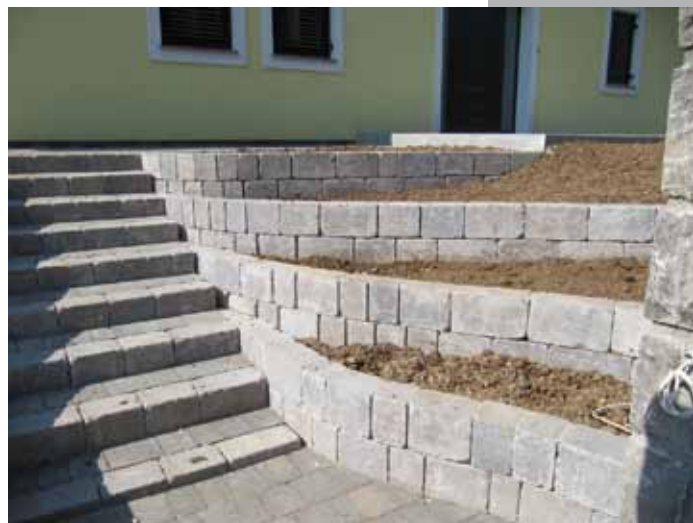
Izdelava kaskad in stopnic iz škarpnih elementov Storica
