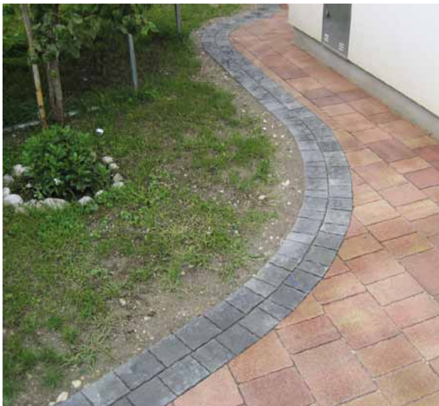
Obbetonirana dvojna obroba ali uporaba sistema Pave edge
