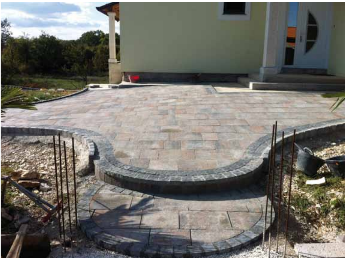
Izdelava "otoka" z dvojno in enojno vrsto tlakovcev Porfido
